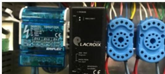
Situé dans le contrôleur, il est **associé à une ou plusieurs boucles magnétiques enterrées sous la chaussée** et capte toute présence ou variation métallique sur celle-ci. Cet équipement est adapté à la détection pied de feu de tous les véhicules et les deux roues motorisés.
