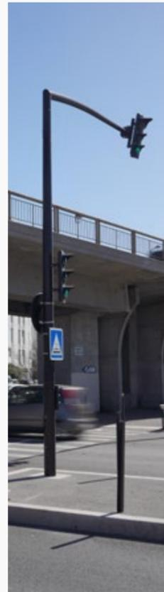
Les potences permettent de positionner sur un carrefour les signaux de signalisation pour offrir une meilleure visibilité et s'affranchir des contraintes terrain (dévers, courbes, arrêts de bus). En aluminium, le déport peut varier de 3m50 à 5m50.
